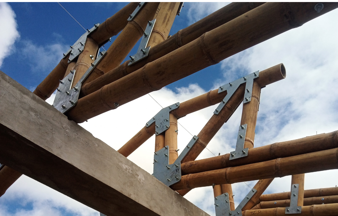
Exemple des assemblages métalliques sur Davu Dago.
