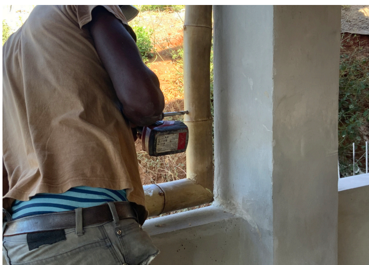
A gauche - JBA, Assemblage du cadre bambou, RDC bâtiment F, Davu Dago, juin 2025.
