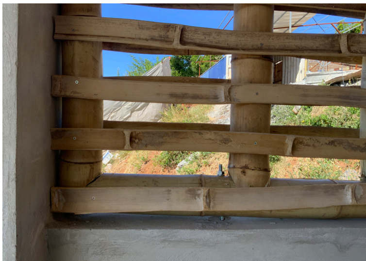
A gauche - JBA, BA, Assemblage du lattis bambou RDC bâtiment F, Davu Dago, juin 2025.
